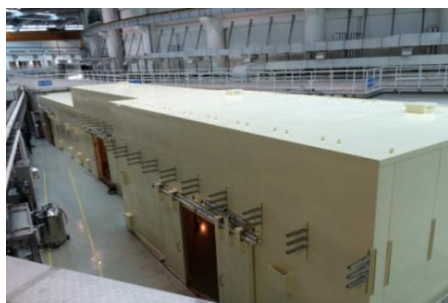
上海光源 X 光学测试线站(BL09B)辐射防护棚屋
