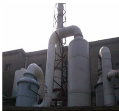
图5 处理能力为 10\,000 \text{ m}^3/\text{h} 的含铍废气处理系统
