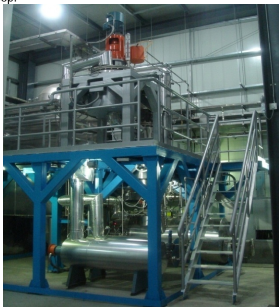
HTS thermal test loop.
