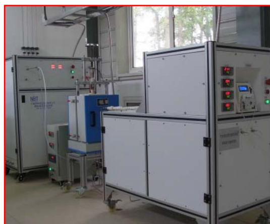
图 10 1 kW 级高温电解制氢平台
