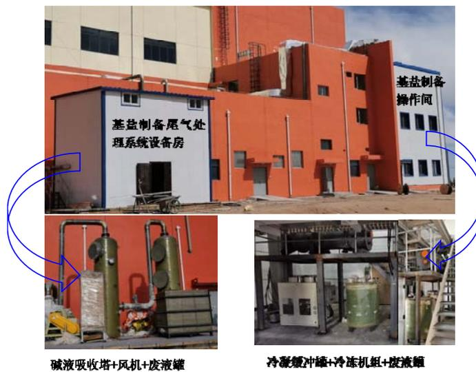
图 1 基盐制备尾气处理系统实物图
