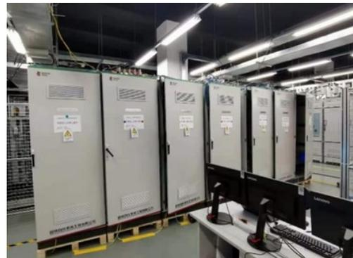
图 1 LF1 棒控棒位 (RGL) 机柜
