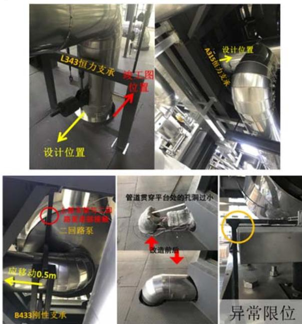
图6 TMSR-SF0管道位移监测过程中发现各类支承问题
